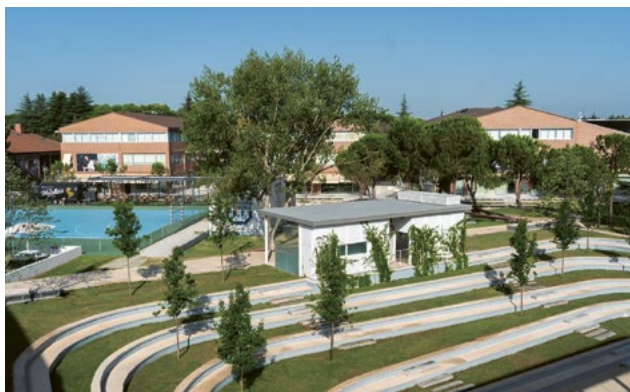
Ilustración 118. Nuevos edificios en el campus UFV
